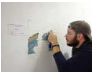
Estudio de paramentos mediante la excavación de catas murarias (Refugio antiáereo del Grupo escolar de l'Ajuntament de València, abril de 2016).
